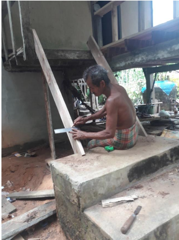
ภาพที่อยู่อาศัยคนพิการ ระหว่างดำเนินการปรับสภาพแวดล้อมที่อยู่อาศัยคนพิการ นายมาหนาบ กองสิน อยู่บ้านเลขที่ ๓/๑ หมู่ที่ ๔ บ้านเกาะหมากน้อย ตำบลเกาะปันหยี อำเภอเมือง
