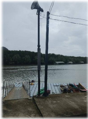
๓. โครงการปรับปรุงเสาไฟฟ้าภายในหมู่บ้าน หมู่ที่ ๓
